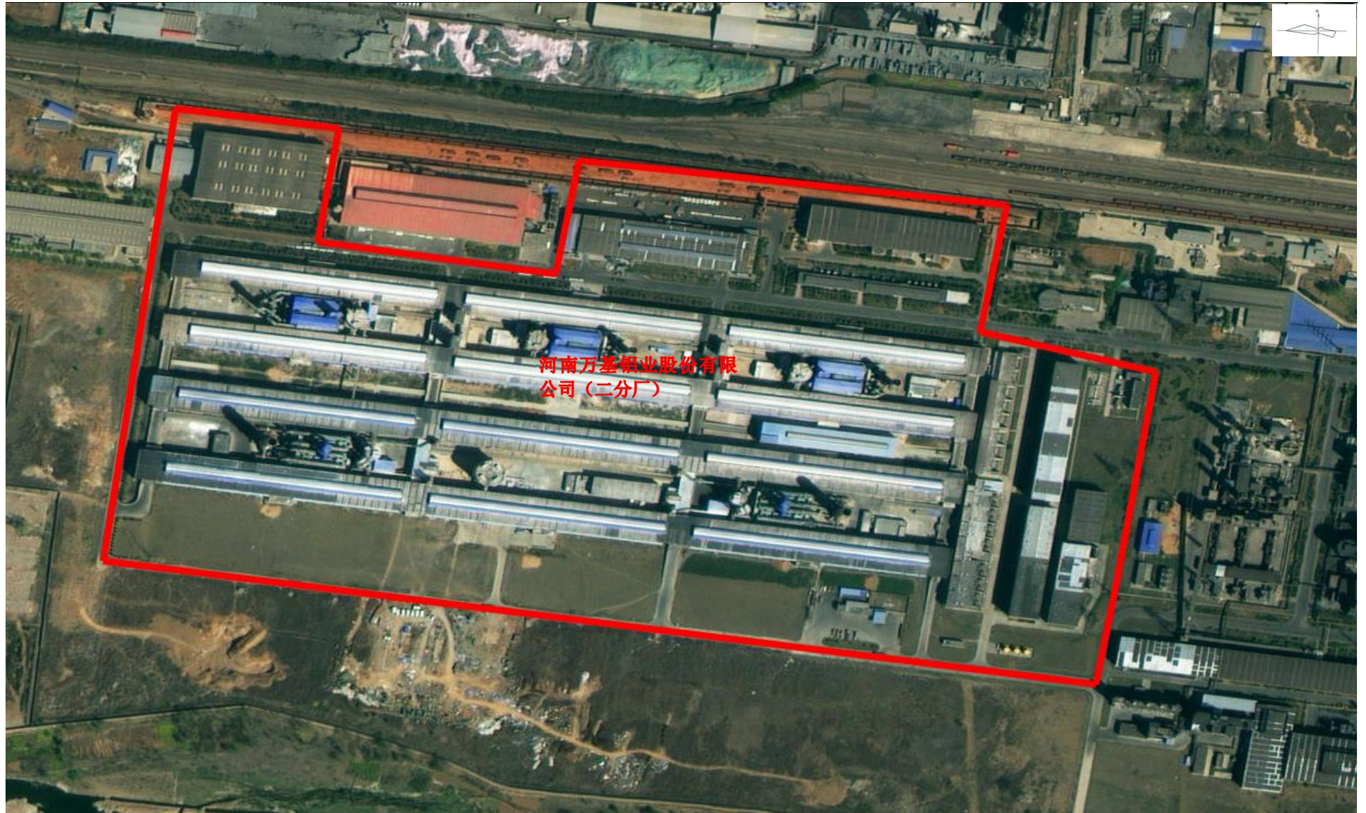
图 1-2 河南万基铝业股份有限公司（二分厂）土壤污染隐患排查范围
