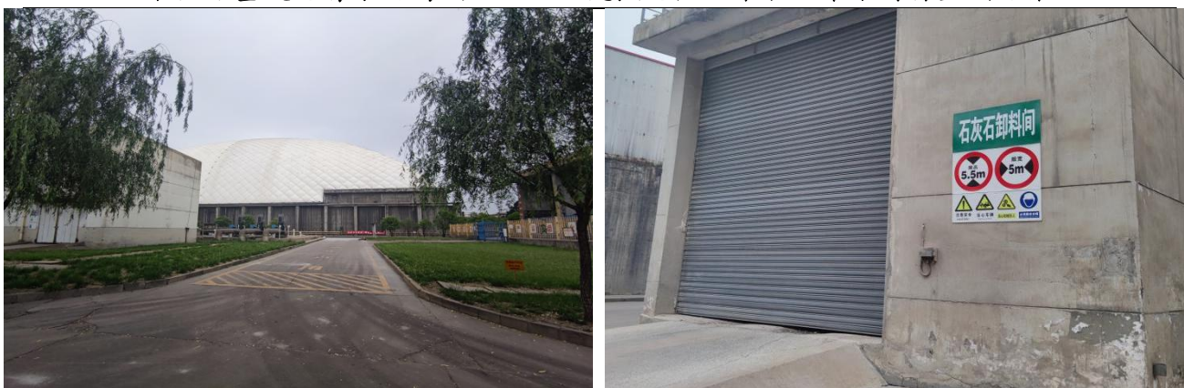
图 5-3 左为封闭煤场，右为石灰石卸料间
