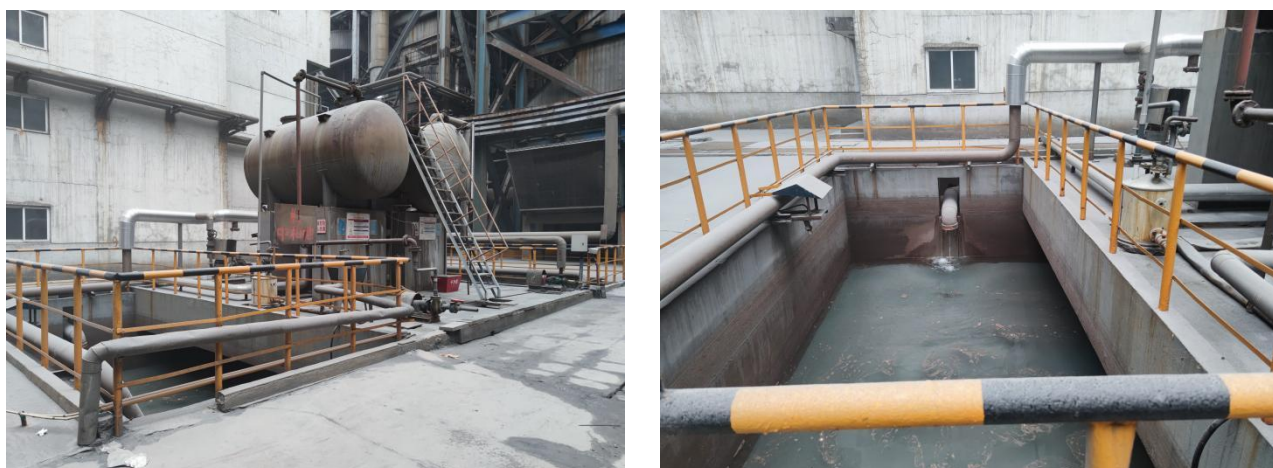
图 5-2-1 锅炉房中和池地下储存池
