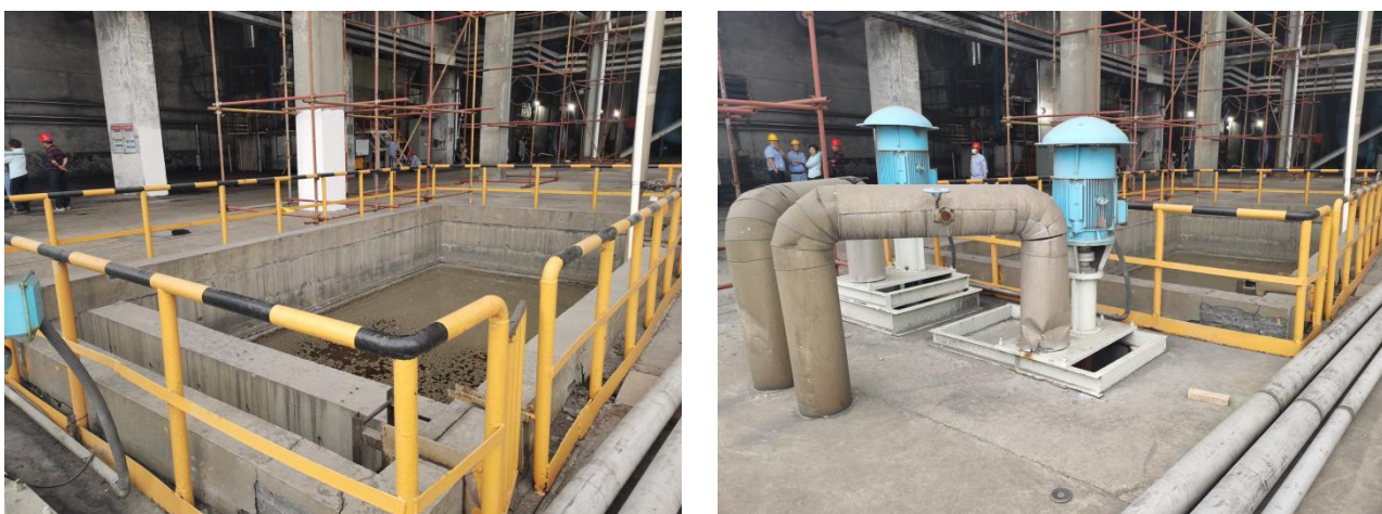
图 5-2-2 事故池地下储存池
